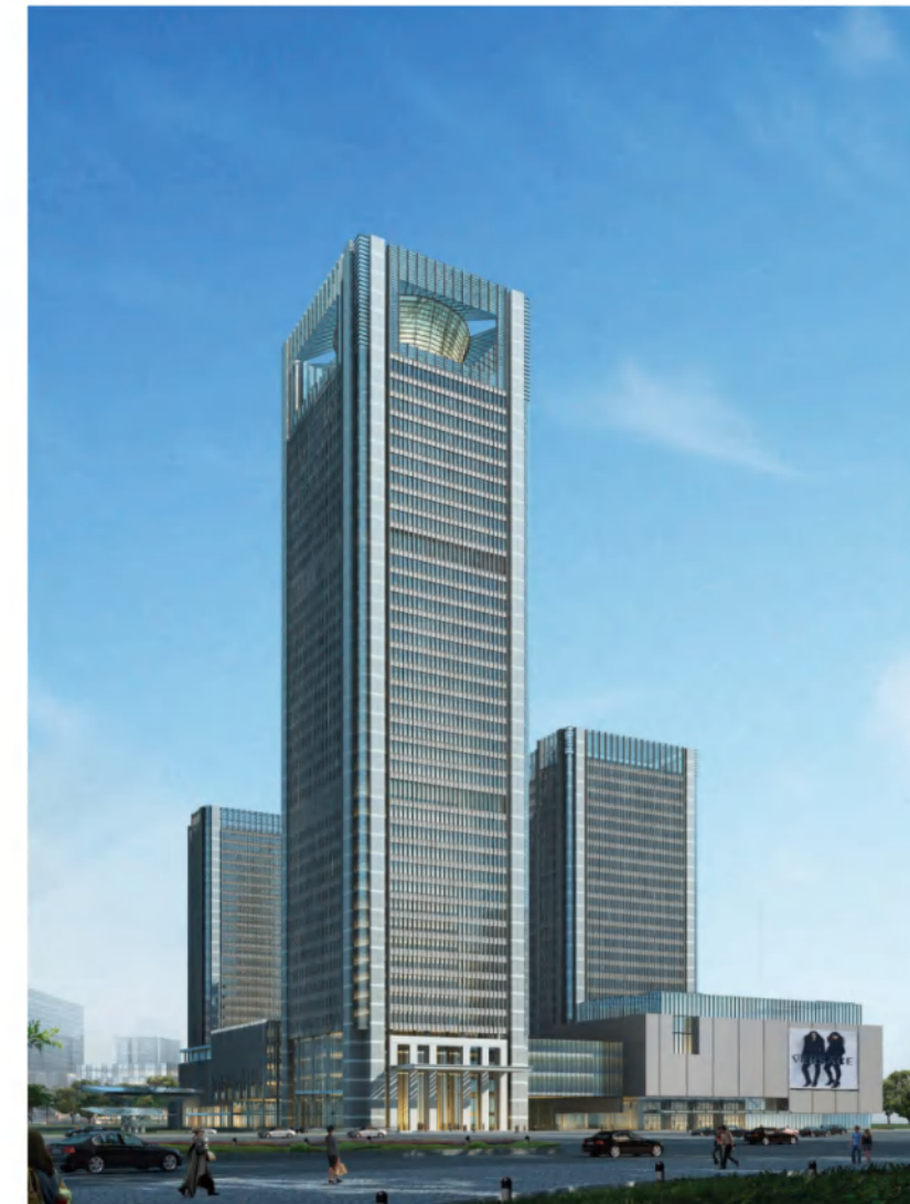
Trung tâm hoạt động tàu điện ngầm Quảng Châu, Trung Quốc Guangzhou Metro Operations Command Center, China
